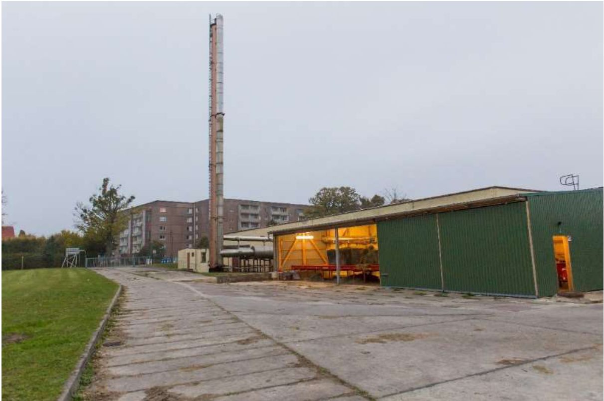
Abbildung 2: Seit 2014 wird in Malchin von der Agrotherm GmbH ein Heizwerk zur thermischen Verwertung von Niedermoorbiomasse betrieben. Foto: www.lensescape.org
