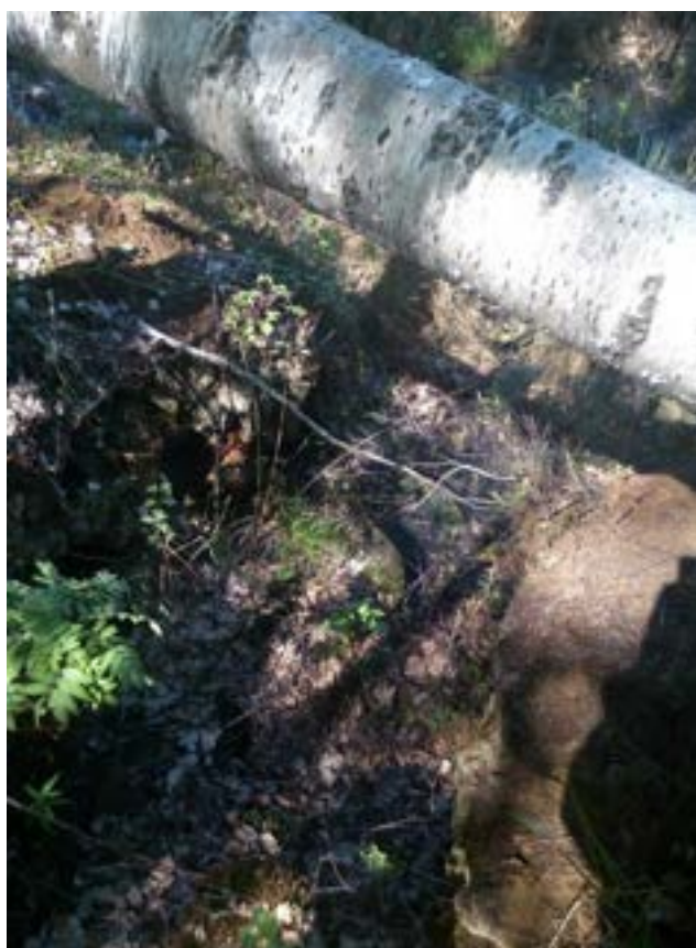
Рис. 10. Ж/б труба на крупном осушительном канале второго типа
